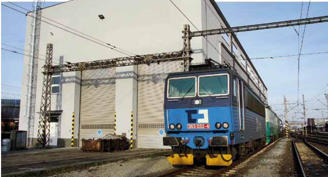
MODERNIZACE. Letos v říjnu skončily práce na rekonstrukci opravárenské haly pro elektrické lokomotivy. FOTO AUTOR (5x)
