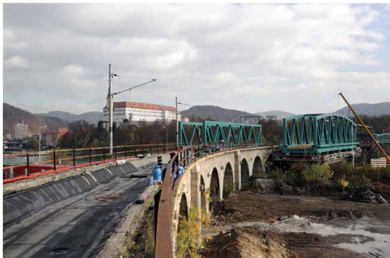
PROMĚNA. Most pod děčínským zámekem dostane nejen novou mostovku, ale i průběžné šterkové lože.
