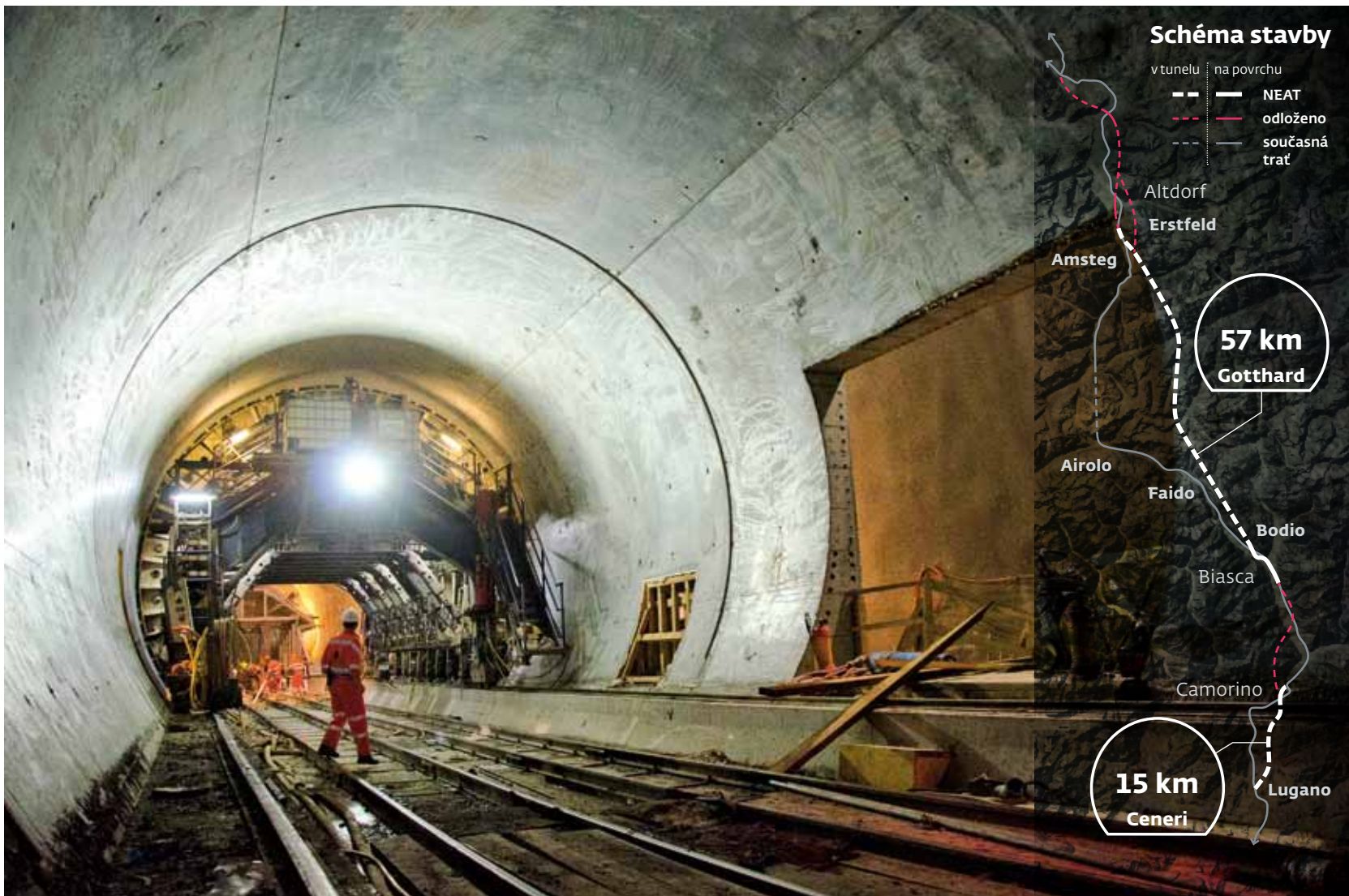
PROVRTÁVAJÍ VELEHORY. Stavební firmy budují pro Novou železniční alpskou transversální dráhu i tunely Gotthard a Ceneri.
