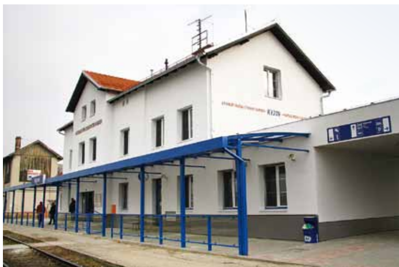
SLOVÁCKO. Rekonstrukce budovy navázala na nový terminál.
