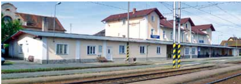
STÁLE JAKO NOVÁ. Výpravní budova ve stanici Horažďovice předměstí prošla zásadní rekonstrukcí v letech 2003–2005. FOTO RSM PLZEŇ
