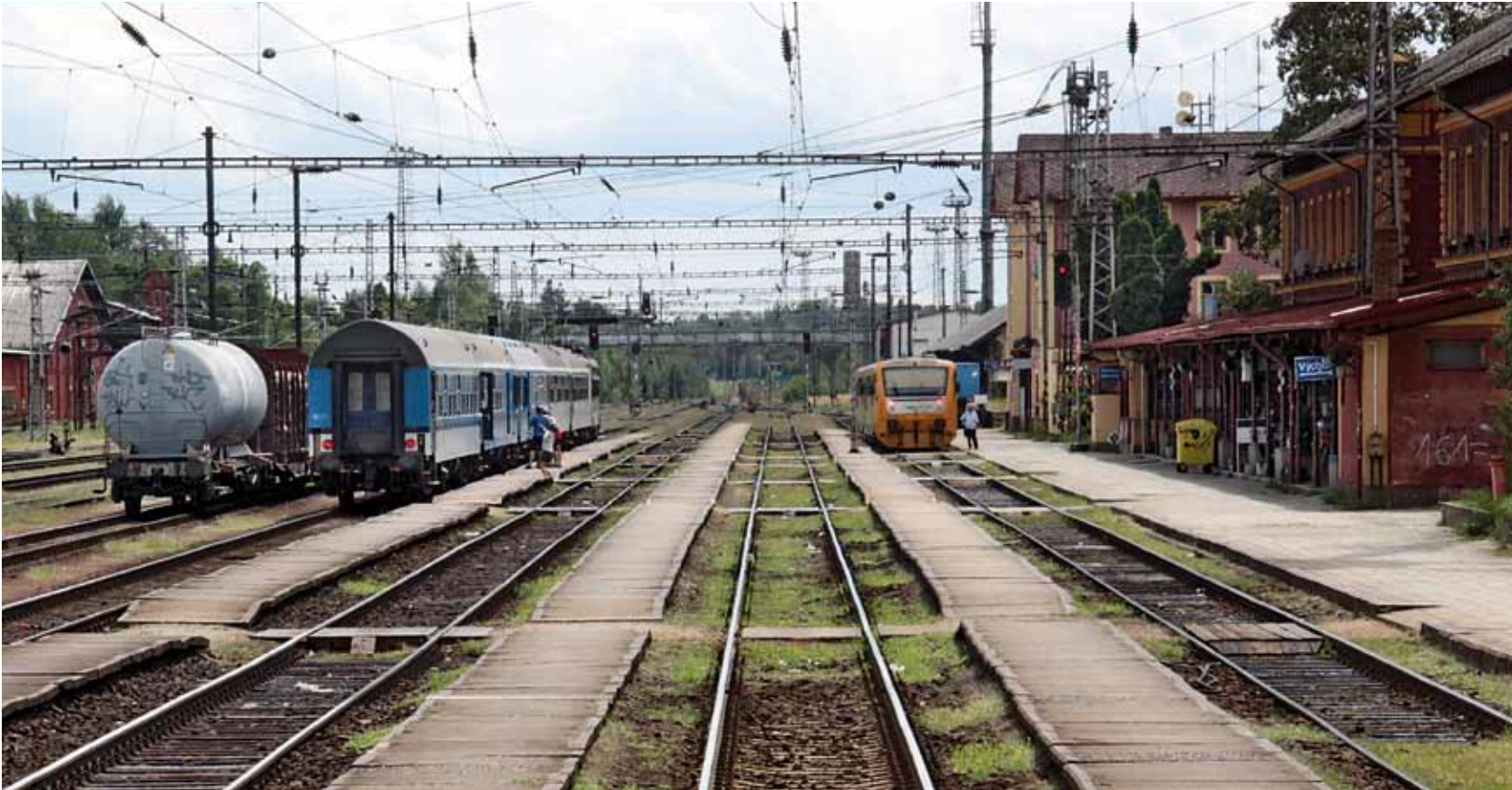
VESELÍ NAD LUŽNICÍ. Výstavba čtvrtého koridoru nyní patří mezi nejvýznamnější investice SŽDC. Část tratě konečně získává druhou kolej.
