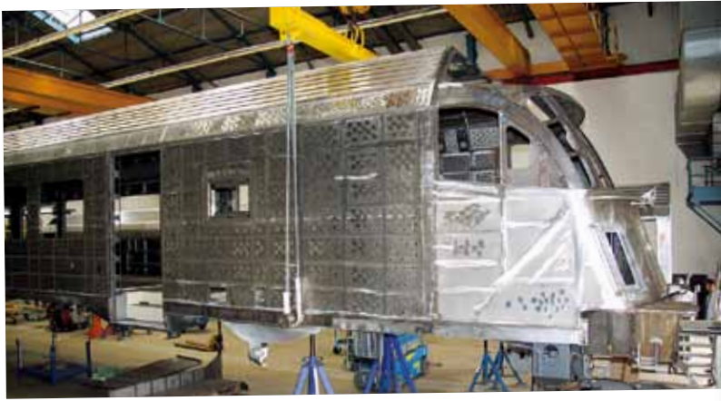
Takto vypadá hrubá stavba řídicího vozu.
