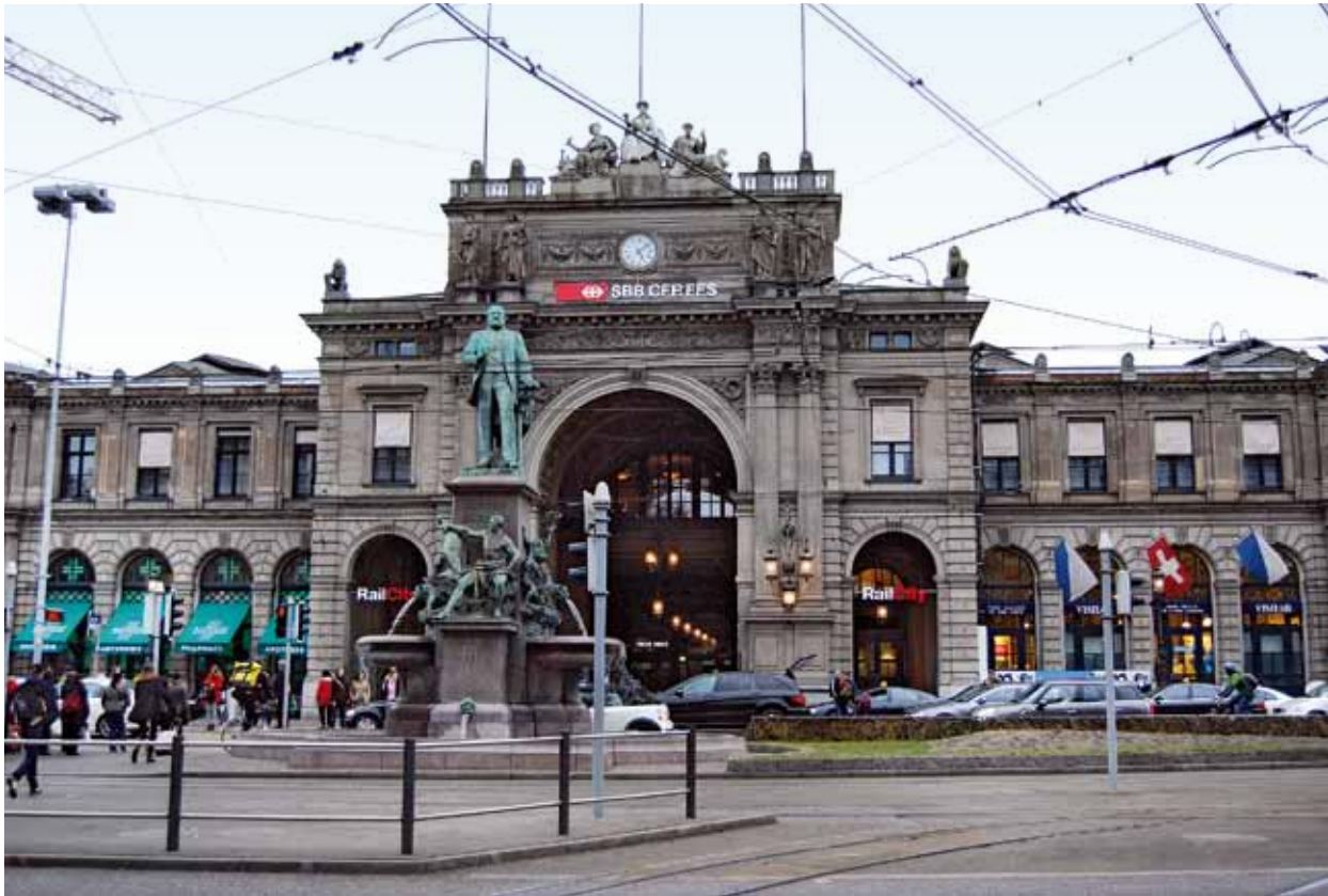
TRIUMFÁLNÍ VCHOD. Budova největšího nádraží ve Švýcarsku pochází z roku 1871. V neorenesančním stylu ji postavil architekt Jakob Friedrich Waner. Prostor před stanicí zdobí socha Alfreda Eschera, průkopníka železnice. FOTO AUTOR
