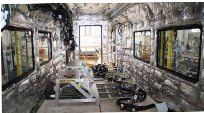
Do každého vozu se musí namontovat kabely různých velikostí a délek.
