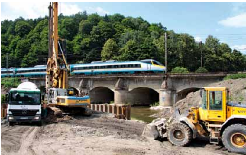
ZATÍM POSTARU. Původní těleso tratě prochází v Ústí nad Orlicí značným obloukem. Po „narovnání“ budou moci vlaky jet výrazně rychleji než dnes.
