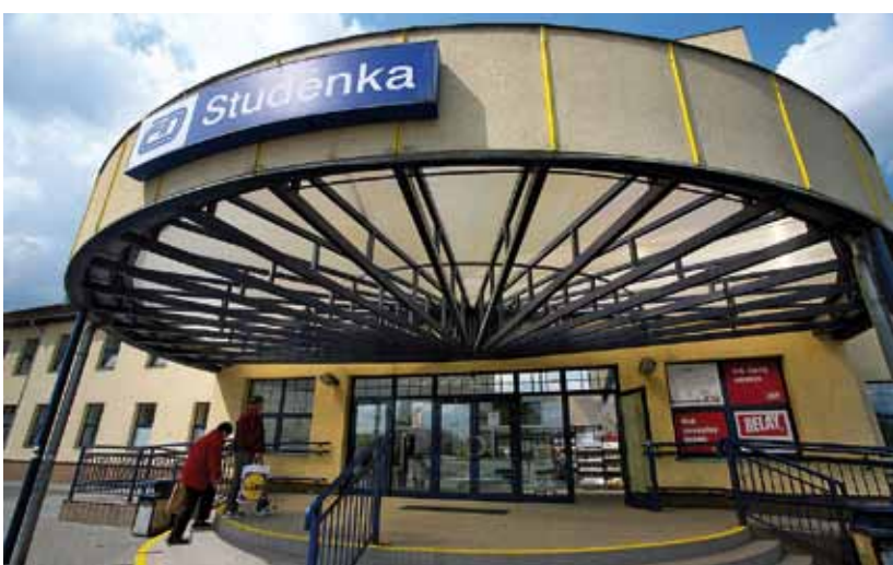
ZAPOČATÉ DÍLO. V dubnu letošního roku začala modernizace přednádražního prostoru ve Studénce. Projekt probíhá ve spolupráci s městem. FOTO MICHAL MÁLEK
