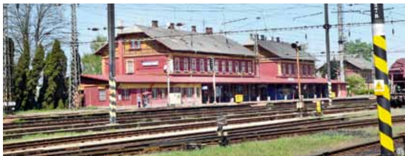
OBJEKT ZÁJMU. Po rekonstrukci se na nádraží rozšíří síť služeb.
