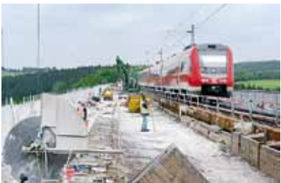
Elektrifikován byl i největší cihlový most na světě.
