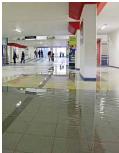
Budova ústeckého hlavního nádraží se plnila vodou. FOTO VÁCLAV RUBEŠ
