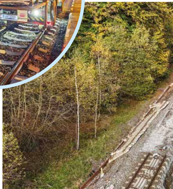
Mezi Hanušovicemi a Brannou probíhají usilovné práce k brzkému zprovoznění.
