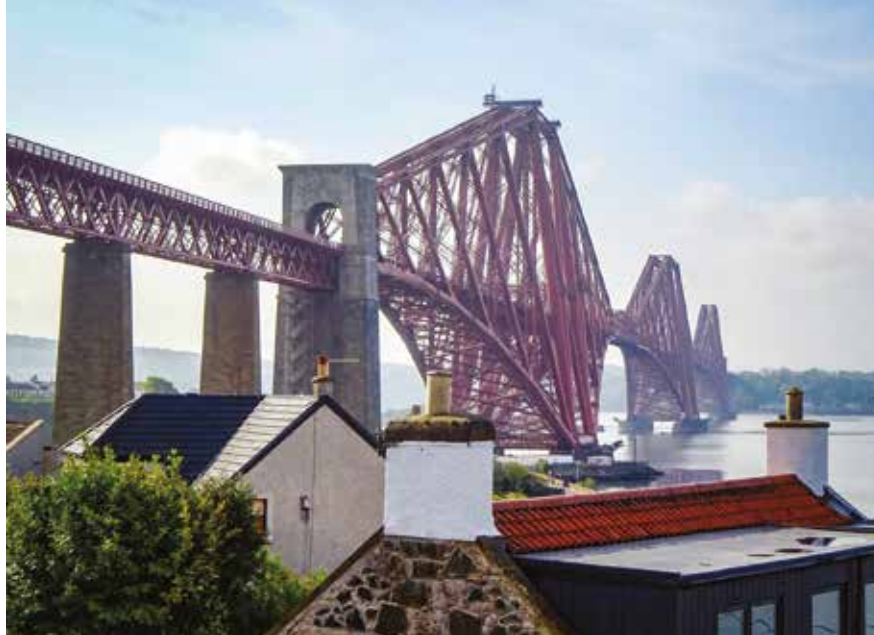
Památkově chráněný Forth Bridge zapsaný na Seznamu světového dědictví UNESCO překonává již od roku 1890 záliv Firth of Forth. Most se stal jedním z prvních ocelových konzolových mostů na světě.
