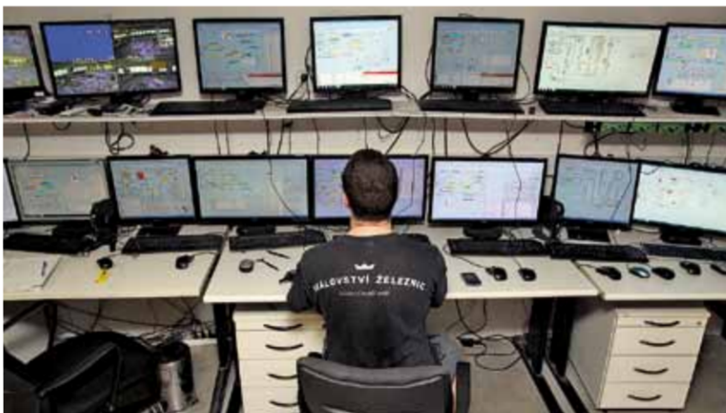
ŘÍZENÍ PROVOZU. Servisní pracovníci tráví asi 90 procent času dohledem nad monitory. Když je ale problém, musí vyrazit „do terénu“.
