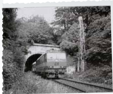
Tunelem pod Vítkovem dnes vede cyklostezka.
