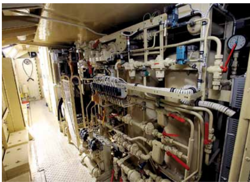
STROJOVNA. Z původních konstrukčních celků zůstalo pouze chlazení trakčních motorů. Lokomotiva nyní umožňuje průchod strojovnou i se zdviženými sběrači.
