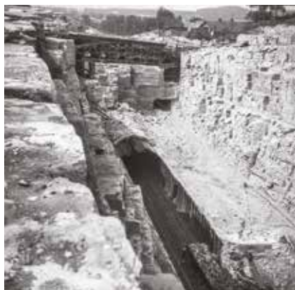
Vznikající zářez v opukovém masivu a stavba silničního mostu nad tunelem, počátek 50. let 20. století. Foto František Anton
