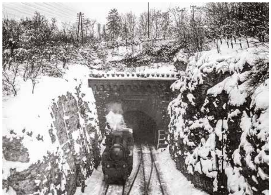
Západní portál tunelu, leden 1929
