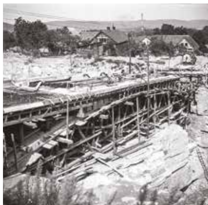
Detail budování silničního mostu nad ještě fungujícím tunelem
