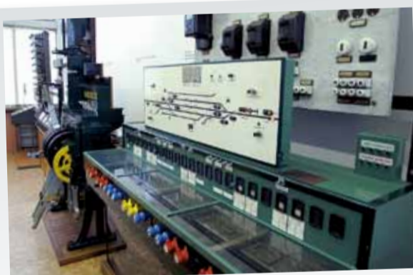
Podobným vývojem jako vlakové zabezpečovače prošla i staniční a traťová zabezpečovací zařízení.
