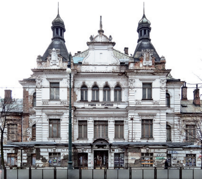
VYŠEHRAĐ. Tato budova již patří soukromému investorovi. FOTO LUKÁŠ BERAN
