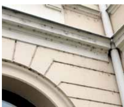
Pavučiny jsou na fasádách, římsách i osvětlení.
