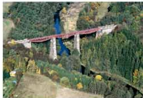
U CHRÁSTKU. Železný most na začátku lokální tratě do Radnic. FOTO: PÁTRÁKOVSKÝ
