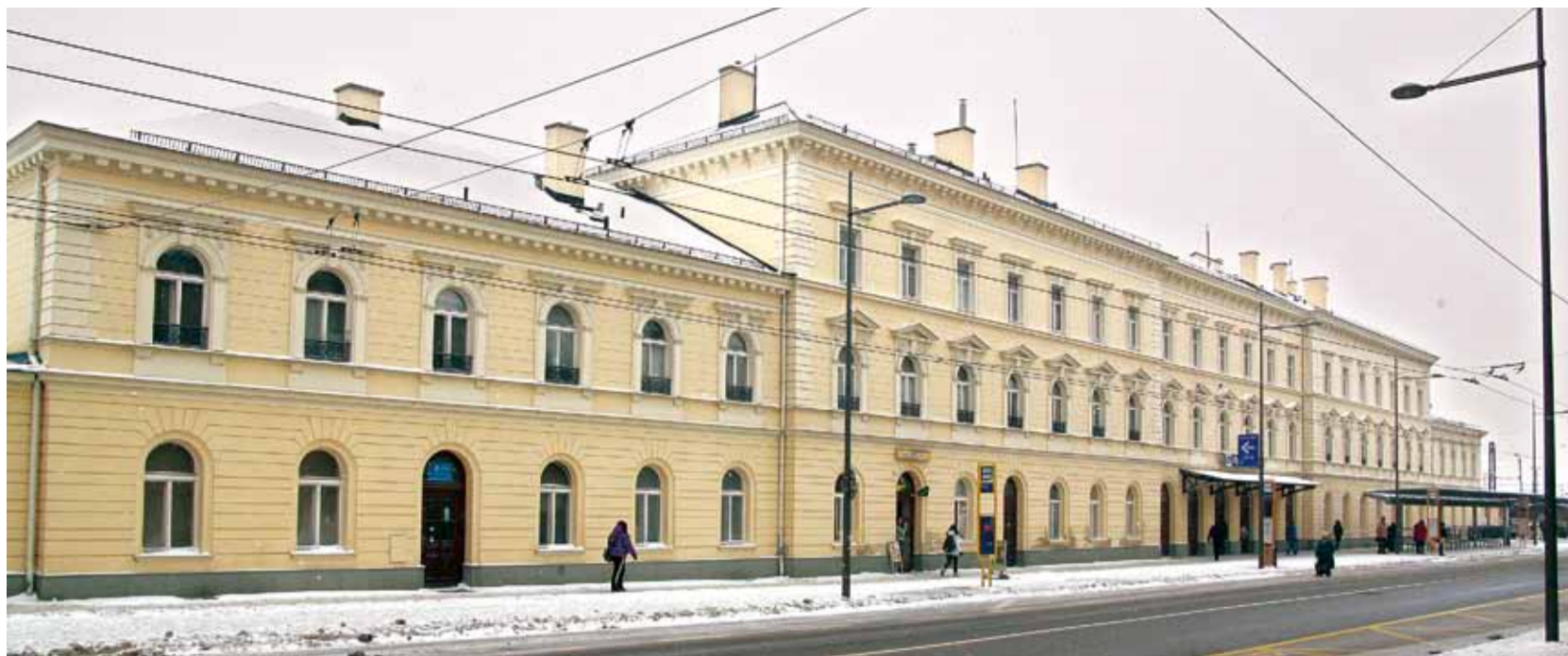
OPRAVENÁ KRÁSA. Výpravní budova Opava východ prošla před lety rozsáhlou rekonstrukcí. Pokud si tu chcete najmout kancelář, máte možnost. FOTO AUTOR (2x)
