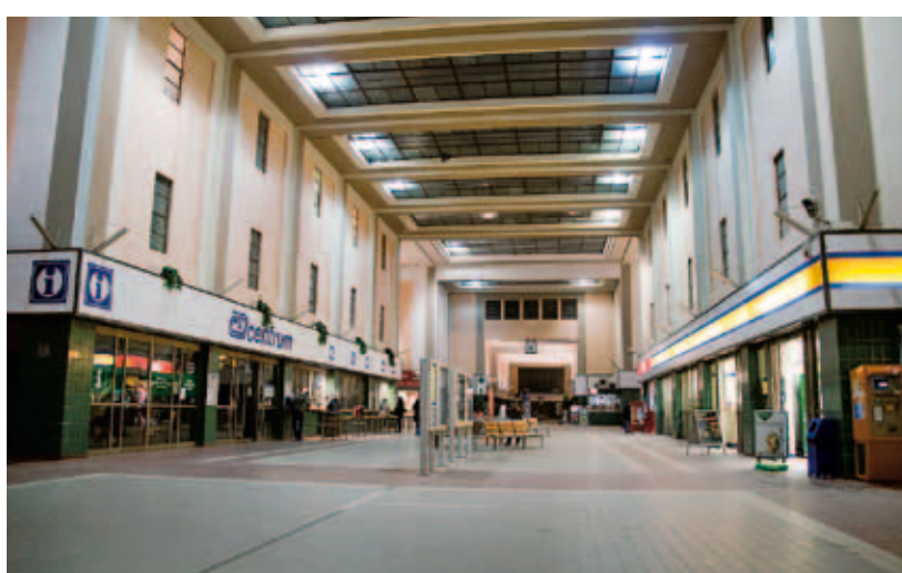
ZÁŘÍME. V rámci hospodaření s nádražními budovami musíme myslet na zajištění dostatečného osvětlení s co nejnižšími náklady.
