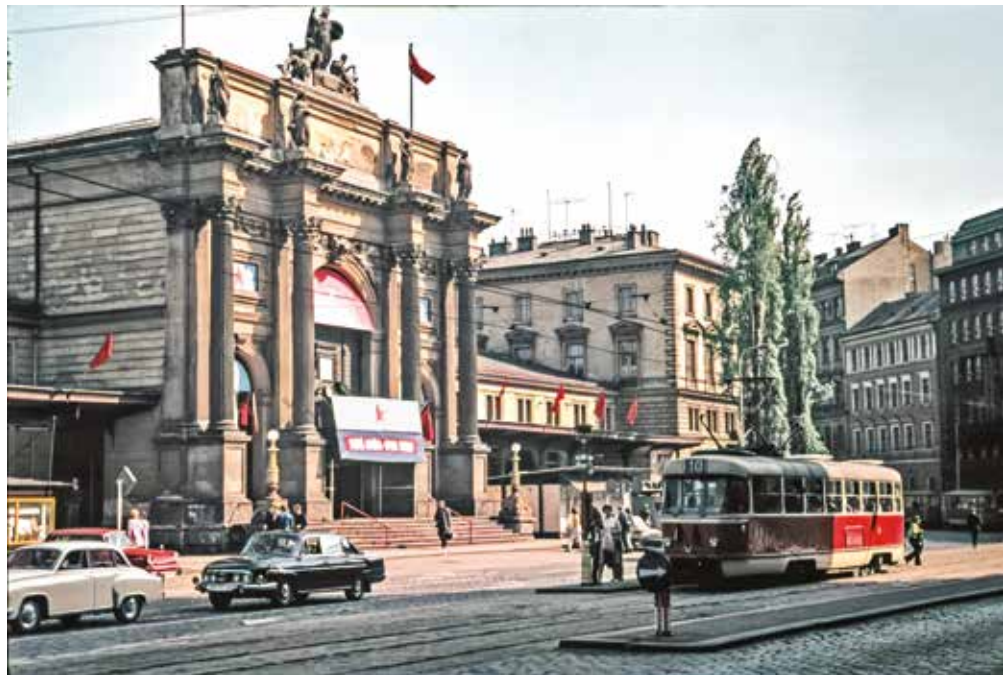
Na konci doby své existence byla budova nádraží ve špatném stavu. Komunistické ozdoby v květnových dnech na krásě nádraží nepřidaly. Ze sloupku zastávky tramvají vyčteme, že zde stavělo sedm linek.
