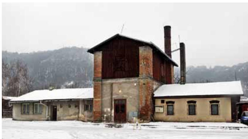
NENÁPADNÁ. Vodárna v Ústí nad Labem-Střekově má status kulturní památky. Před deseti lety se o ni začali starat členové Zubrnické muzejní železnice.
