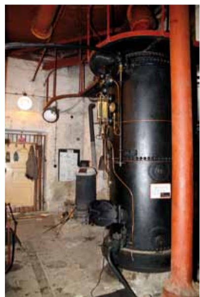
Jako nový vypadá stojatý kotel vodárny z 30. let minulého století.
