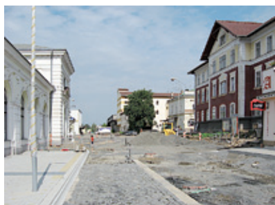
Rekonstrukce se dotkla i prostor uvnitř budovy.
